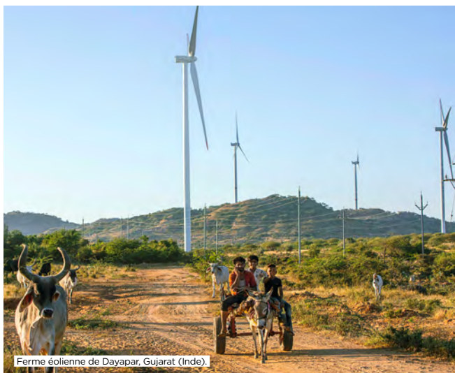
Ferme éolienne de Dayapar, Gujarat (Inde).
