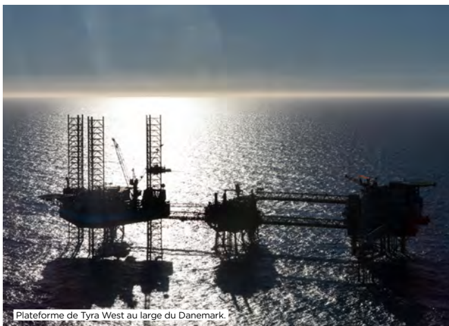
Plateforme de Tyra West au large du Danemark.
